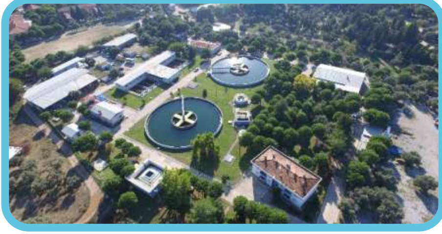
Topyatağı İçme Suyu Arıtma Tesisi
