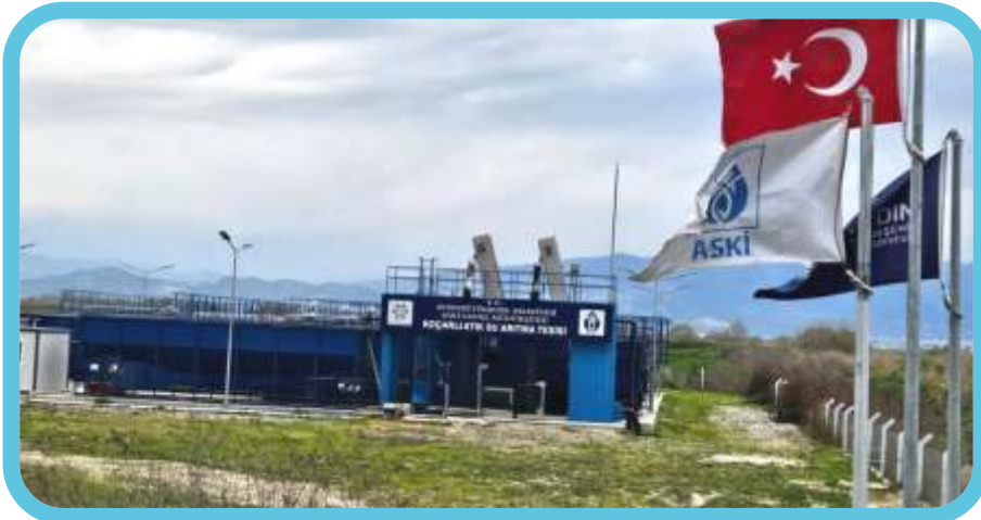
Koçanlı Atık Su Arıtma Tesisi
