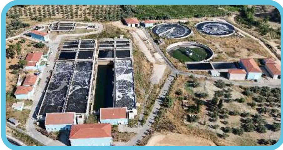
Kuşadası İleri Biyolojik Arıtma Tesisi
