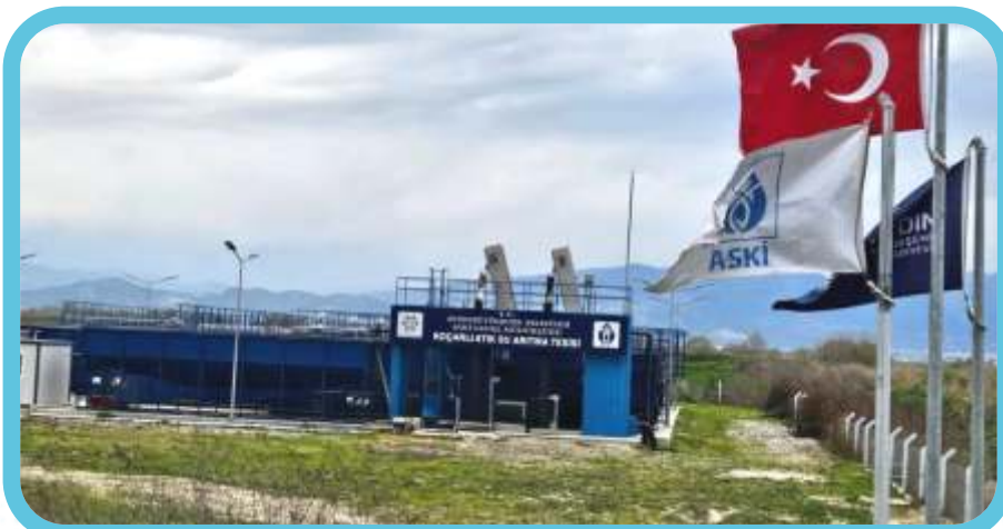
Koçarlı Atık Su Arıtma Tesisi
