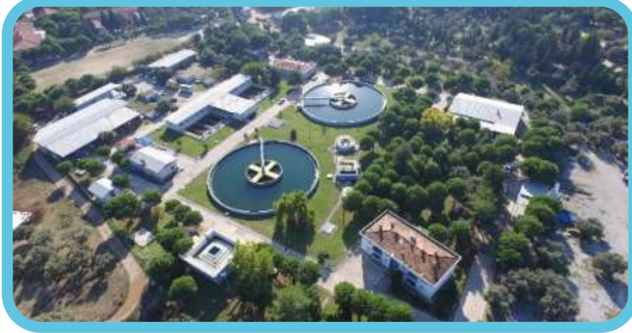
Topyatağı İçme Suyu Arıtma Tesisi
