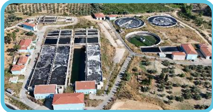
Kuşadası İleri Biyolojik Arıtma Tesisi
