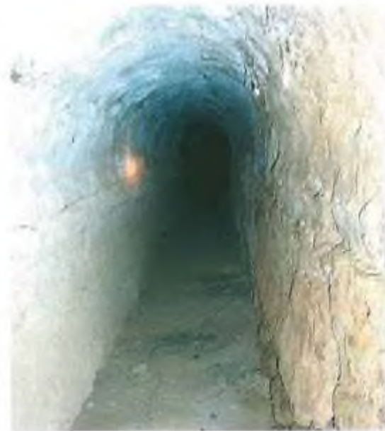
Res. 6. Tralleis'e su taşıyan Taşkemer'in akışağısından görünüş. Su, Taşkemer'den sonra 4 450 km'lik bir geçişle Tralleis'e ulaşıyor.
