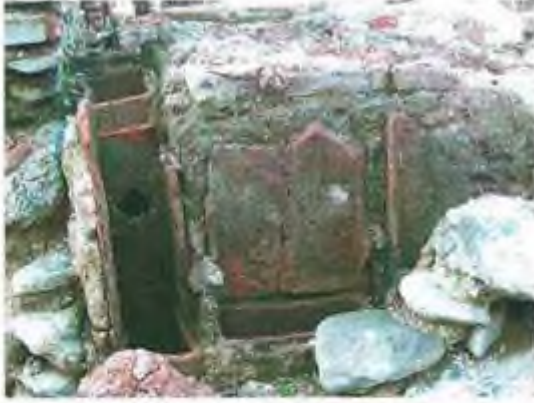
Res. 3. Tralleis'in Roma Devri hamamının duvarları içine gizlenmiş duman bacası.
