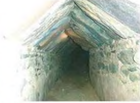
Res. 4. Tralleis su sisteminin Taşkemer-Kızılarkulesi arasındaki bölümünde yer alan üçgen tepeli galeri.
