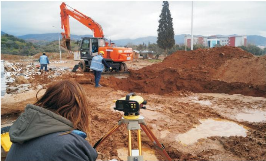
Efeler - Mimar Sinan Mahallesi kanalizasyon hattı çalışması
