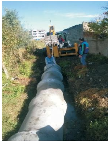
Çine - Cumalı Mahallesi kanalizasyon hattı çalışması
