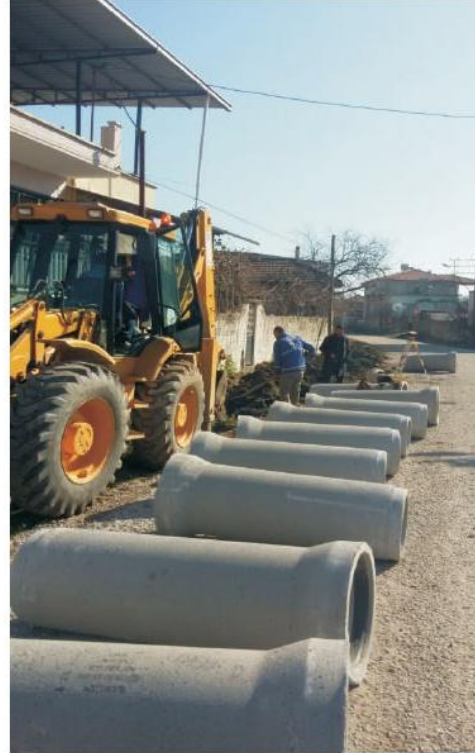
İncirliova - Osmanbükü Mahallesi yağmur suyu hat çalışması
