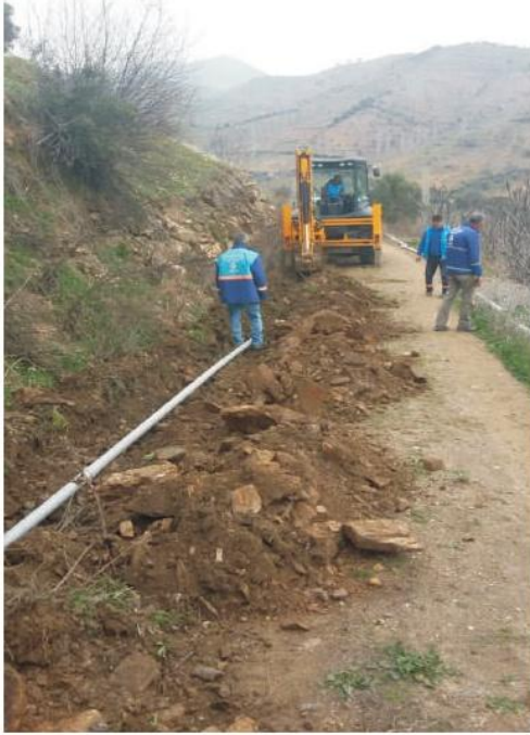
İncirliova - Beyköy Mahallesi sulama suyu hat çalışması
