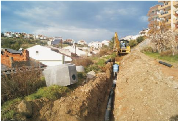
Kuşadası - Kadınlar Denizi Mahallesi kanalizasyon hat çalışması
