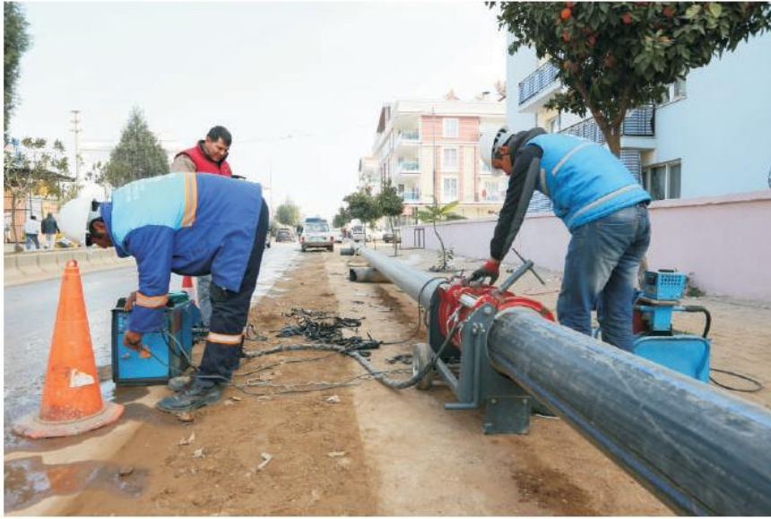
Efeler - Kemer Mahallesi içme suyu isale hattı çalışması
