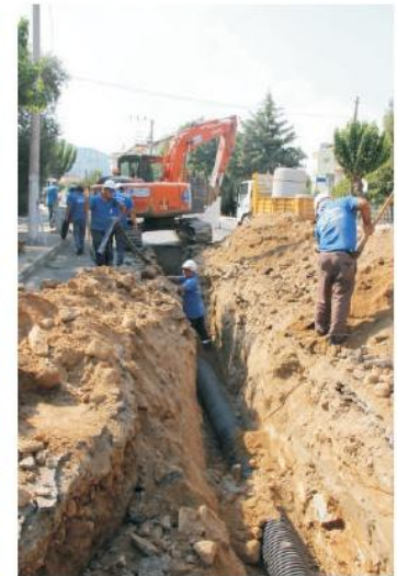
Bozdoğan - Merkez kanalizasyon hattı çalışması
