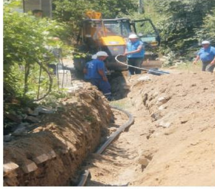
Sultanhisar - Atça Mahallesi içme suyu hat çalışması
