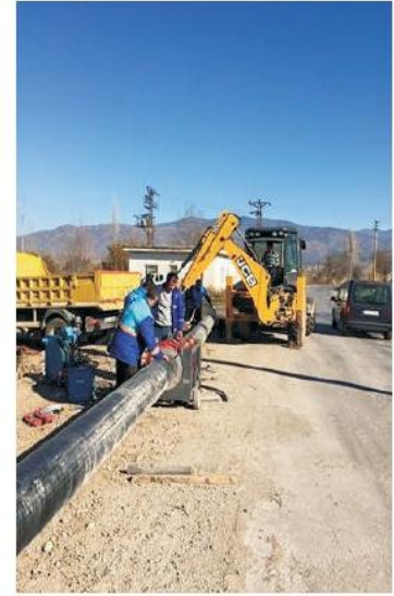
Bozdoğan - Konaklı Mahallesi içme suyu isale hattı çalışması
