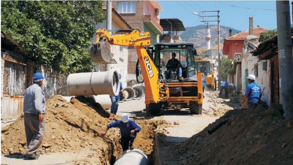
Kuyucak - Pamukören Mahallesi kanalizasyon hat çalışması
