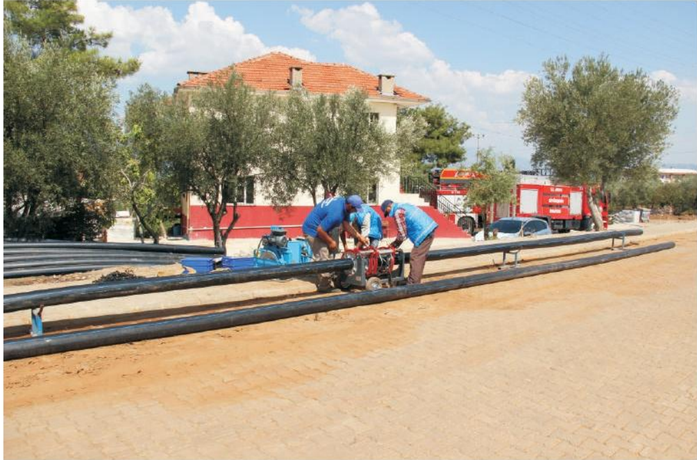
Karacasu - Merkez içme suyu isale hat çalışması
